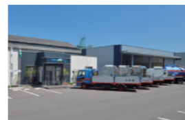
工事業は各種プラントのメンテナンス・解体・洗浄を展開しています。
