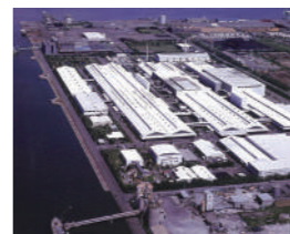
YKKAP 株式会社 九州製造所のリフォーム塗装工事
